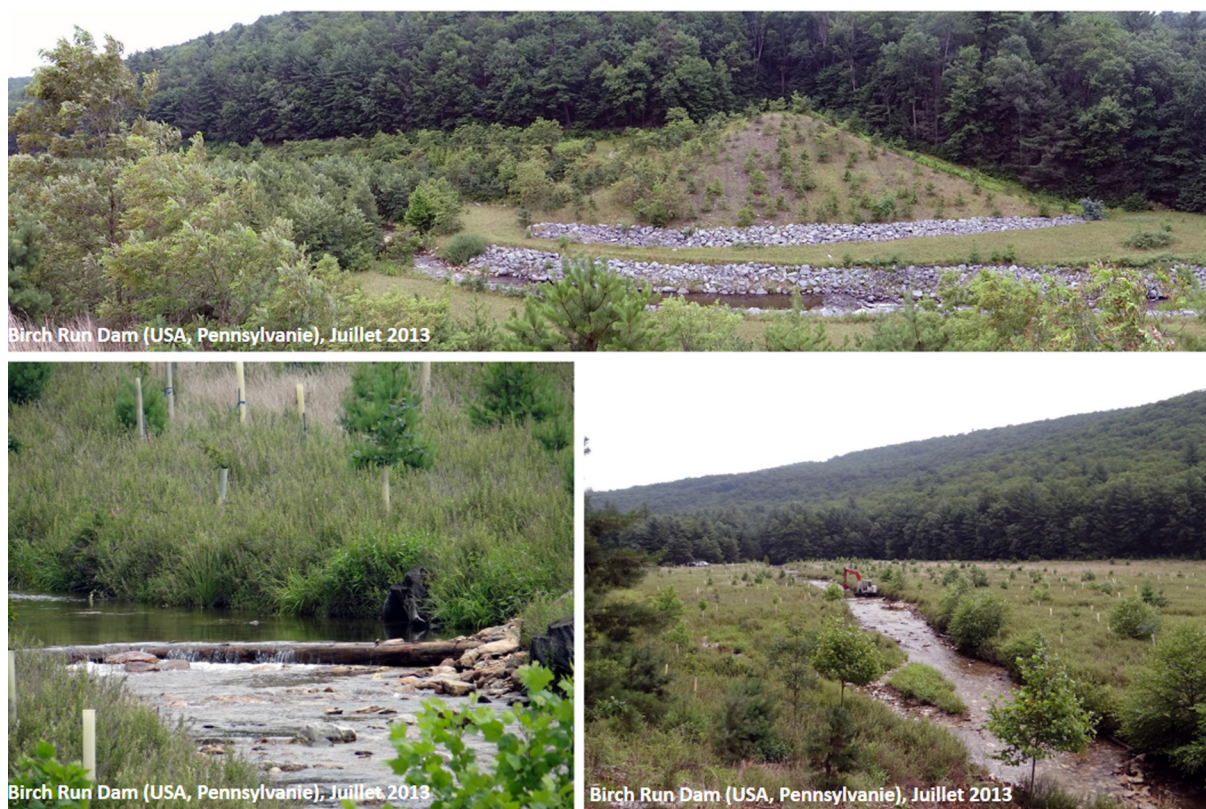
Figure 7. Site du Birch Run Dam sur la Conococheague Creek (Etats-Unis, PA) : arasement du barrage (en haut vue de l'ancien ouvrage depuis la rive droite) et reconfiguration de la rivière et de la plaine alluviale (vue depuis l'aval, en bas à droite et à gauche) : enrochements transversaux, création de 32 seuils artificiels en pierres et troncs immergés en V, plantations en aval et amont de l'ouvrage supprimé sous forme d'une ripisylve et d'une opération de boisement du fond de vallée
