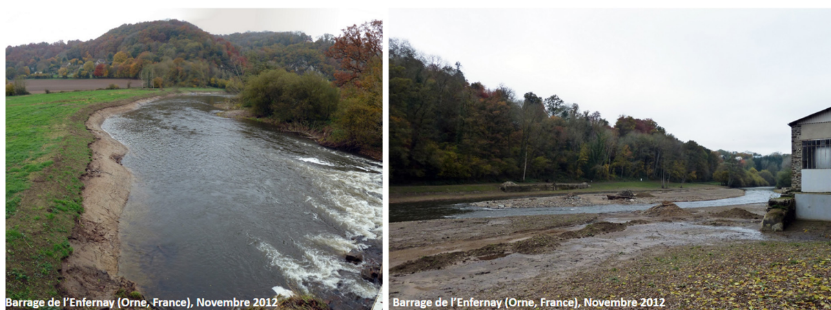
Figure 4. Site du barrage de l'Enfernay sur l'Orne (Calvados, France). À droite vue de l'amont vers l'ancienne zone d'influence ; à gauche vue de l'amont du site hydraulique avec l'ancienne usine en rive droite et des vestiges des aménagements en rive gauche. Arasement de l'ouvrage en travers et reconfiguration du chenal (berges talutées munies à l'amont de l'ancien ouvrage d'une terrasse submersible, façonnement d'une île et de deux bras au droit du barrage, recharge caillouteuse et enrochement de la pointe de l'île, reconstitution d'une ripisylve étagée, réaménagement d'un sentier de randonnée en rive gauche
