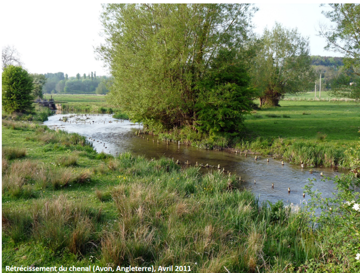
Rétrécissement du chenal (Avon, Angleterre), Avril 2011 Figure 10. Exemple d'opération de rétrécissement de chenal par l'utilisation de pieux et de fascines submersibles sur l'Avon (Angleterre)
